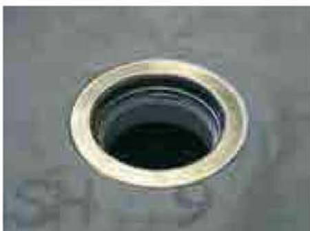
10. Зажать фильтрующий слой фиксирующим фланцем элемента HL350.0
