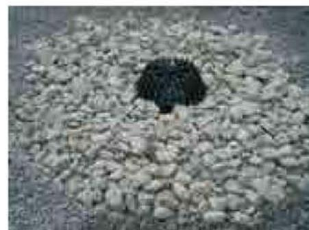
12. Засыпать гравием остальную поверхность кровли
